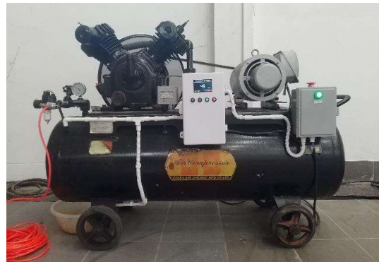
รูปที่ 7 ปั๊มลมที่ประกอบชุดควบคุมเสร็จสมบูรณ์
